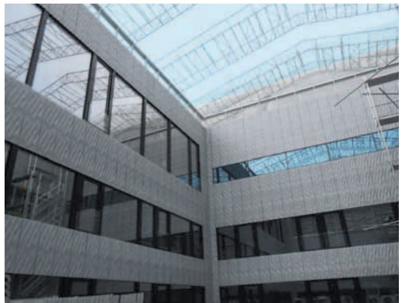
Von der Baustelle zur Ausführung: einige Durchgangsphasen bis zur Fertigstellung der Gebäudeverkleidung auf Seiten der Innenhöfe.
