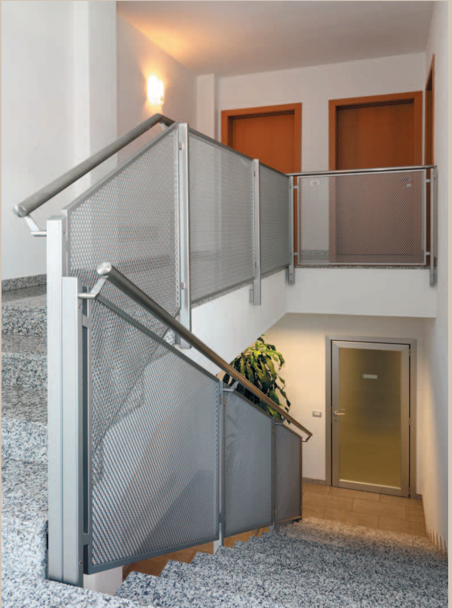
Masche: DL 28 x DC 16 - av 3 x sp 2 mm - Stahl, Sendzimir-verzinkt, lackiert Foto: Studio Diecidodici
