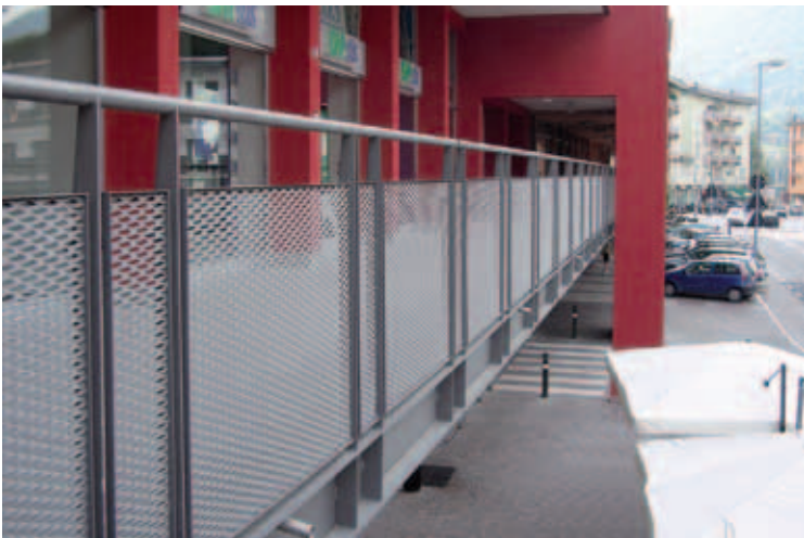
Projekt: Metalltech - Masche: Fils 5 - DL 62,5 x DC 20 (20) - av 7,5 x sp 1,5 mm Verzinkter Stahl, lackiert
