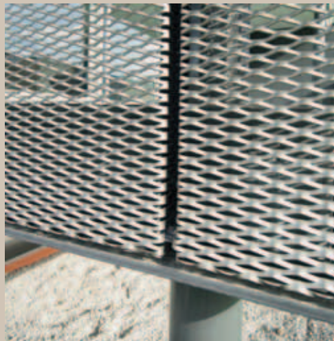
Projekt: Dachtler Partner AG (CH) - Masche: Fils 5 - DL 62,5 x DC 20 (20) - av 7,5 x sp 1,5 mm Aluminium Natur - Foto: Huber
